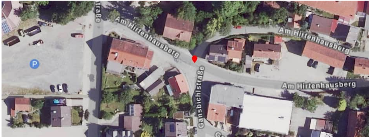
Abbildung 13: Luftbild Knotenpunkt Am Hirtenhausberg/ Gansbichlstraße (Quelle: Bayerische Vermessungsverwaltung, 2024)
