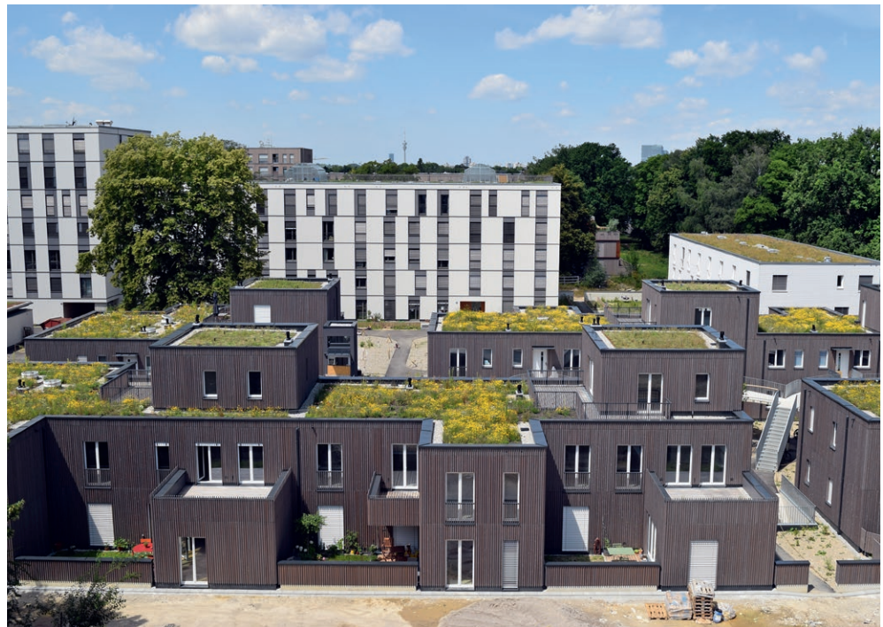
Abb. 21: In der Ökologischen Mustersiedlung wurden verschiedene Klimaanpassungsmaßnahmen integriert, etwa Dachbegrünung.
