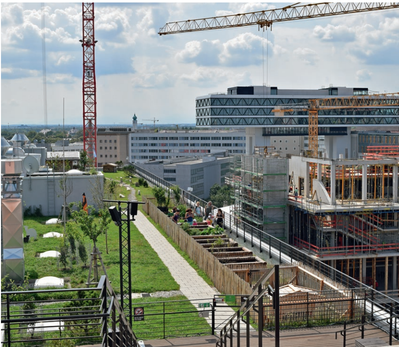
Abb. 22: Blick über die „Stadtalm“ auf dem Dach des Werk3
