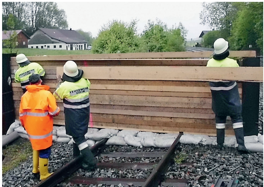
Abb. 24: Bislang wird ab einem bestimmten Wasserstand der Iller in Immenstadt eine mobile Hochwassersperre aufgebaut. Da sie über die Bahnstrecke Kempten – Immenstadt verläuft, muss der Zugverkehr dann eingestellt werden.
