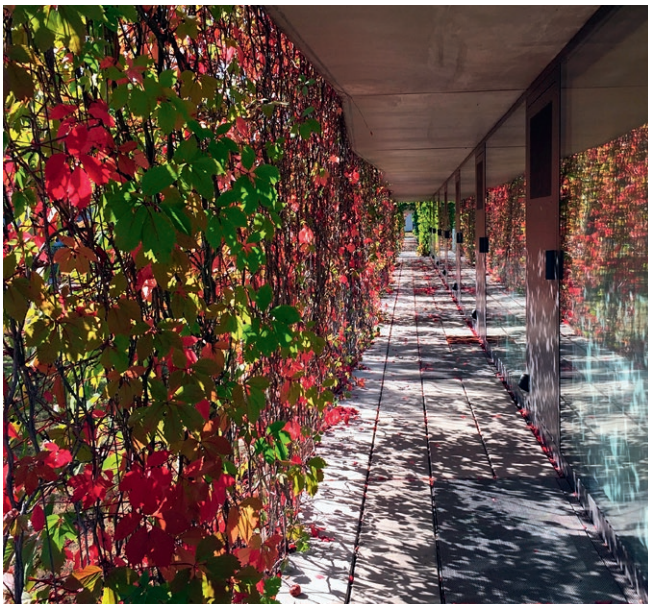
Abb. 32: Die Laubgänge des Studentenwohnheims in Garching könnten als Vorbild dafür dienen, wie Wege auf ansprechende Weise beschattet und begrünt werden können.
