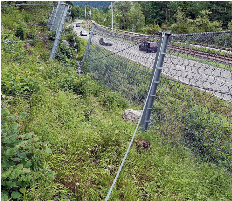
Abb. 25: Ein neu errichteter Steinschlagschutzzaun schützt die Verkehrsteilnehmenden auf der Bundesstraße 2, nördlich von Oberau vor Felsblöcken aus dem etwa 150 m hohen Hang.
