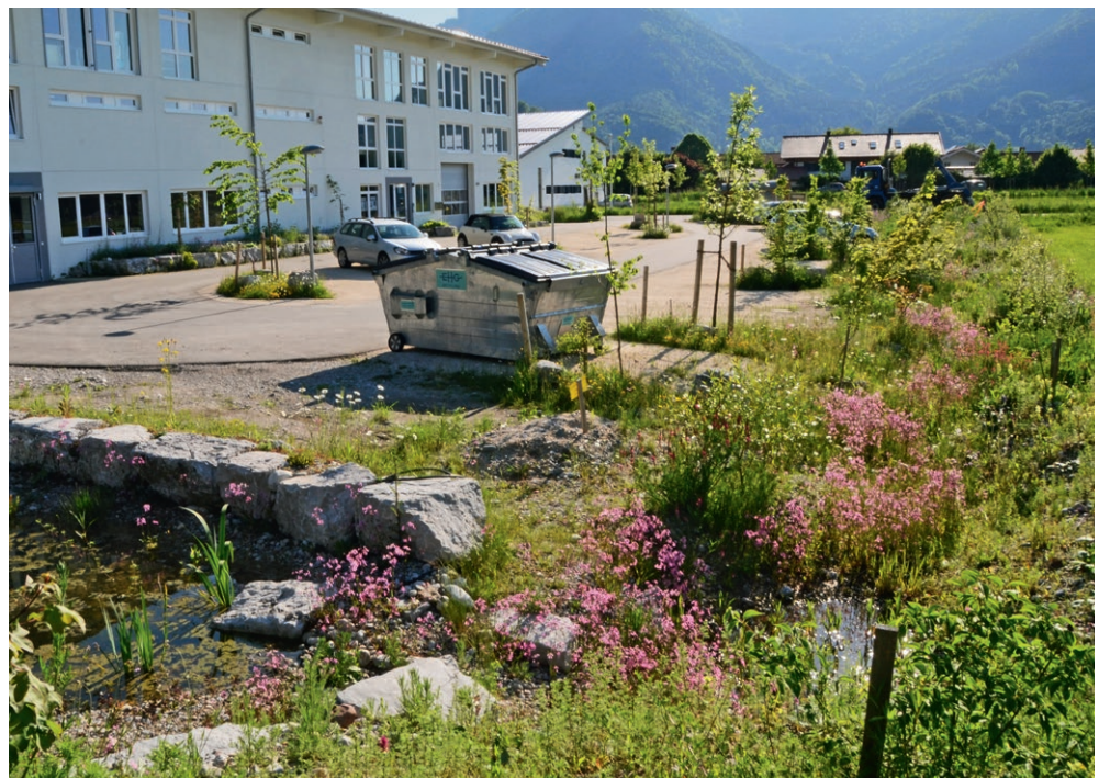
Abb. 27: Der Parkplatz von Skywalk mit Regenwasser-Ver-sickerungsmulden am Rand des Geländes. Nur die stark frequentierte Durchfahrt wurde asphaltiert.
