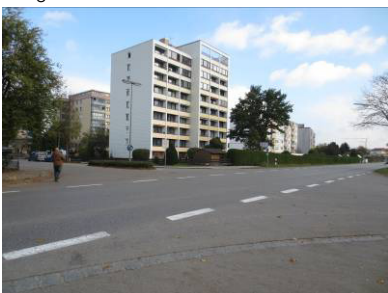
Momentane Situation Ortseinfahrt Karwendelstraße
