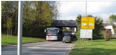
Momentane Situation Bahnunterführung Mindelheimer Straße
